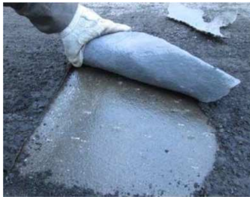
写真－2. 1 防水層の損傷事例
